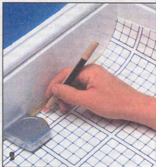
Чтобы точно отрезать полотно по длине, на нем делают с помощью рулетки отметку, например, в 20 см от стены.
