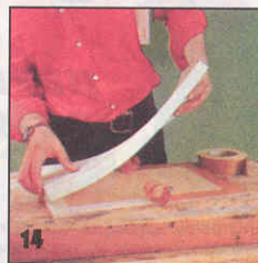
14 Подушки из пеноматериала приклеивают двухсторонней клейкой лентой к основаниям.
