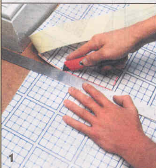
Так вырезают «язык», который будет входить в нишу в стене.
