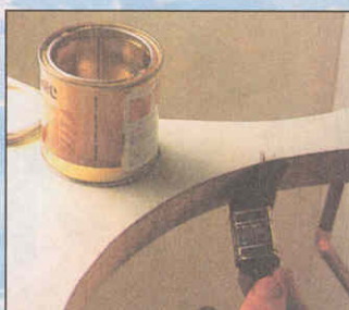
Кромки проема для мойки закрашивают или промазывают герметиком.
