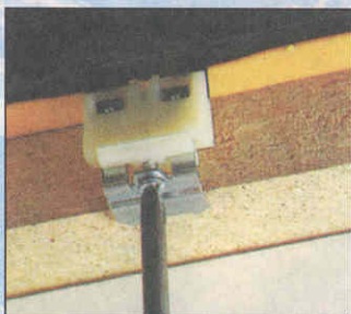
При монтаже эмалированной мойки затягивать винты крепежных скоб следует осторожно, т.к. при деформации мойки эмаль может треснуть!
